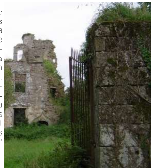
Le portail d'entrée et une lucarne.
