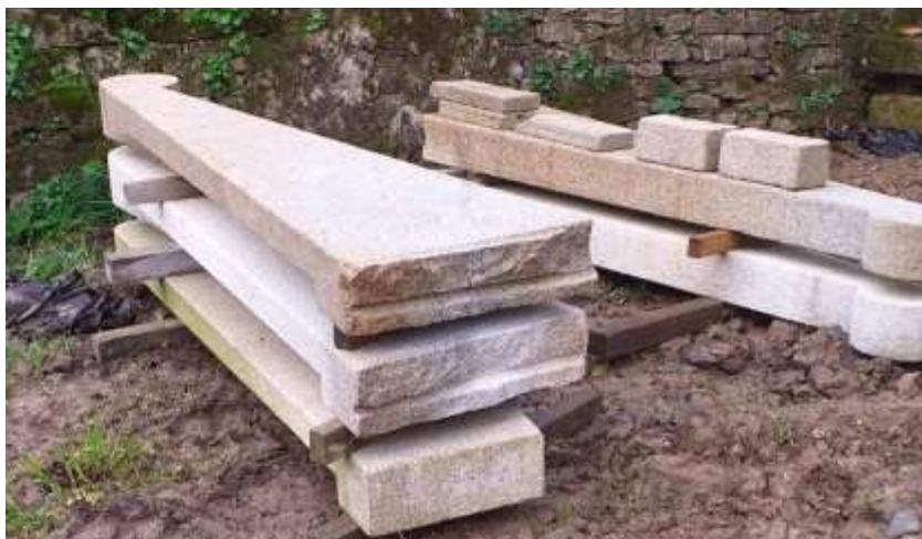
5 des 7 marches à remplacer ont été livrées.
