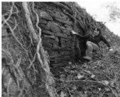
Dévégétalisation des murs d'enclos
